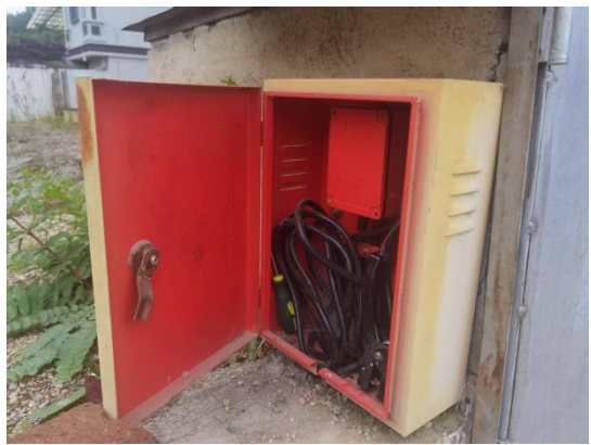
卸油口一侧静电接地夹
