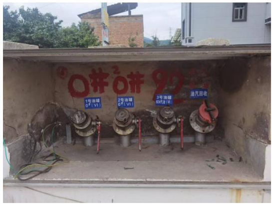
卸油口一侧静电接地夹
